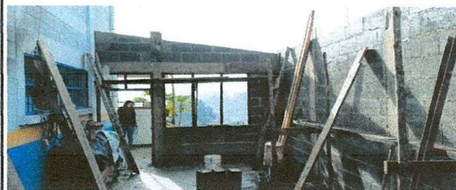
Foto 2: REPARACIÓN Y MANTENIMIENTO DEL ÁREA DE COCINA
