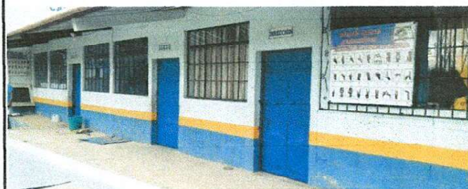
Foto 6: MANTENIMIENTO DE PINTURA PUERTAS
