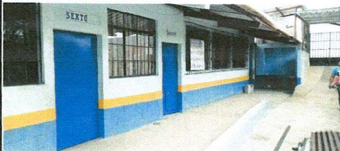
Foto 1: SUSTITUCIÓN DE CANALES Y BAJADA DE AGUA PLUVIAL
