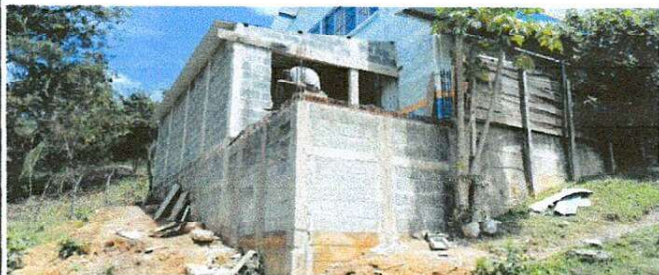
Foto 1: REPARACIÓN DEL ÁREA DE COCINA
