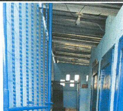
Foto 4: MANTENIMIENTO DE PINTURA EN ÁREA DE LOS BAÑOS Y CUBIERTA DE LAMINA
