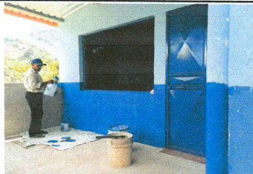
Foto 2: PINTURA DE MUROS E INSTALACION DE PUERTA Y VENTANA ÁREA DE COCINA
