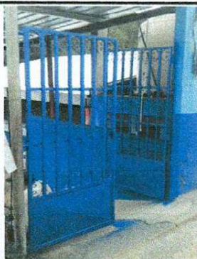
Foto 3: MANTENIMIENTO DE PINTURA DE PORTÓN ENTRADA PRINCIPAL
