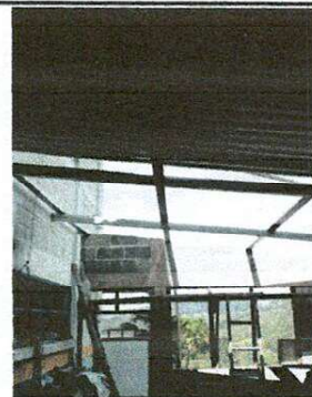
Foto 4: PROCESO DE INSTALACIÓN NUEVA ESTRUCTURA DE METAL
